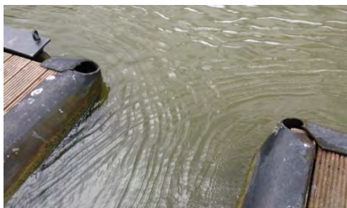
Opstuwing → bovenstroomse kant
